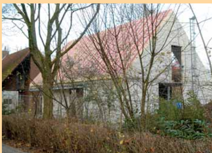
Thomas van Aquinostraat Tilburg, 12 appartementen
