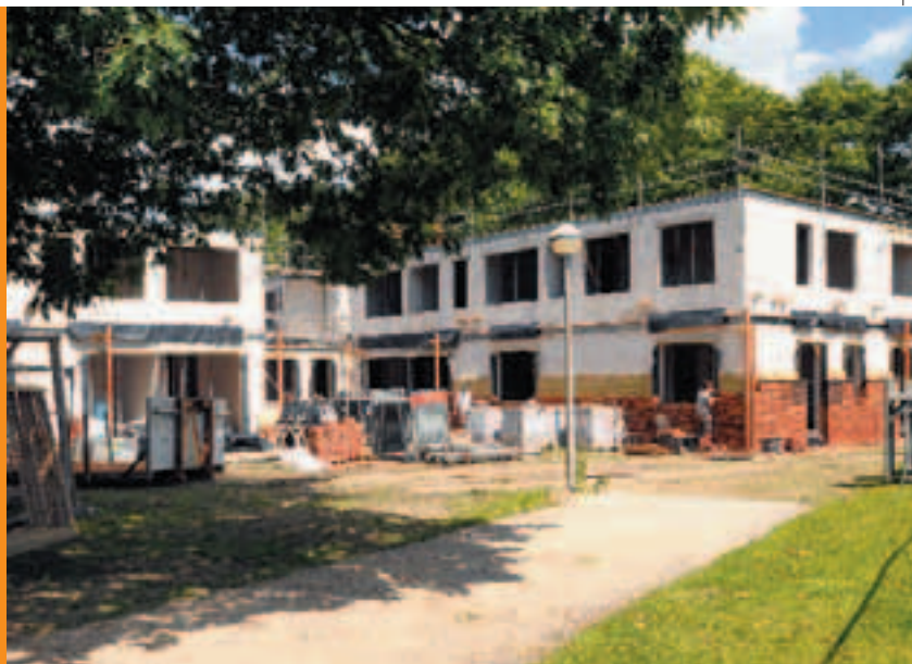
Bouwactiviteiten aan de Spie Tilburg
