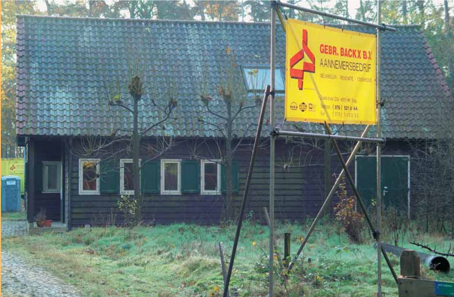
De werkschuur wordt opgeknapt
